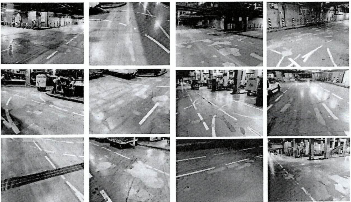
รูปที่ 28 ผลลัพธ์การซ่อมแซมพื้นผิวถนนในพื้นที่ Sorting Area อาคาร MTB
