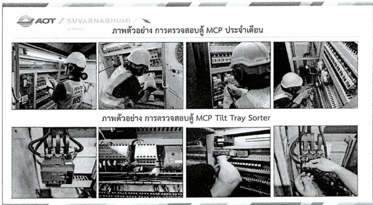
รูปที่ 24 การตรวจสอบอุปกรณ์ Auxiliary Contact และ Magnetic Contractor ในตู้ MCP
