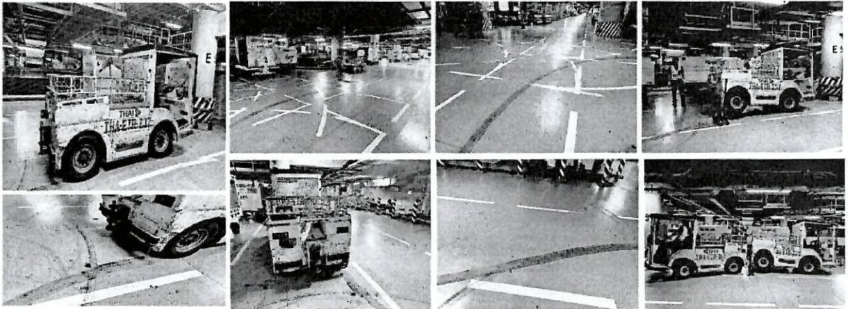
รูปที่ 13 คราบน้ำมันบริเวณ MU28 อาคาร MTB
