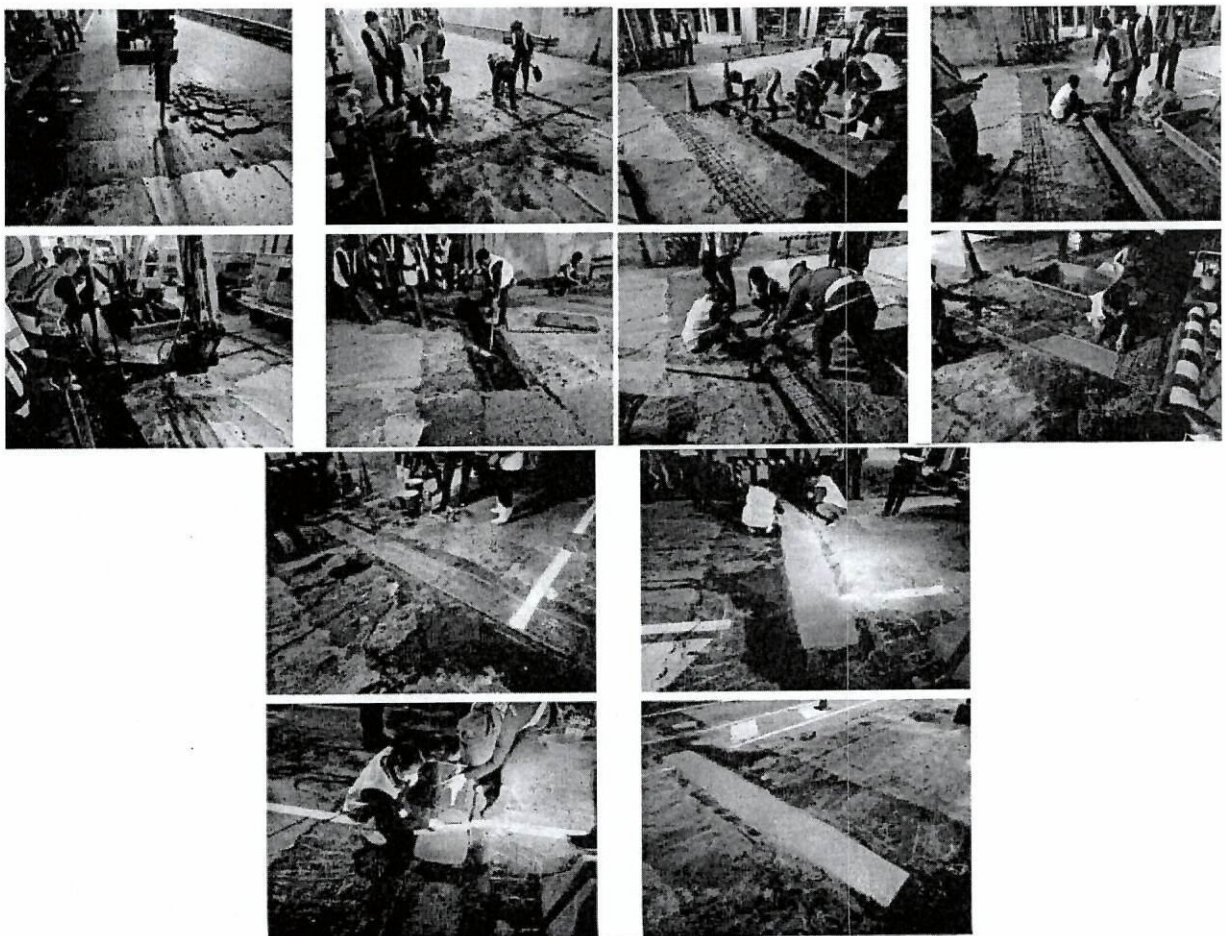
รูปที่ 34 การดำเนินการซ่อมแซมพื้นผิวถนนบริเวณรางระบายน้ำตรง Ramp ฝั่งตะวันออก อาคาร MTB
